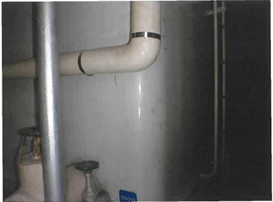
物件 2 5階水槽室
