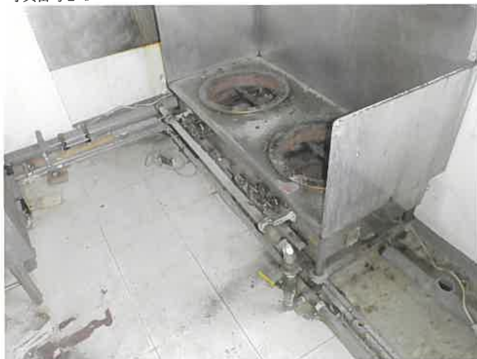
物件 2 3階厨房跡
