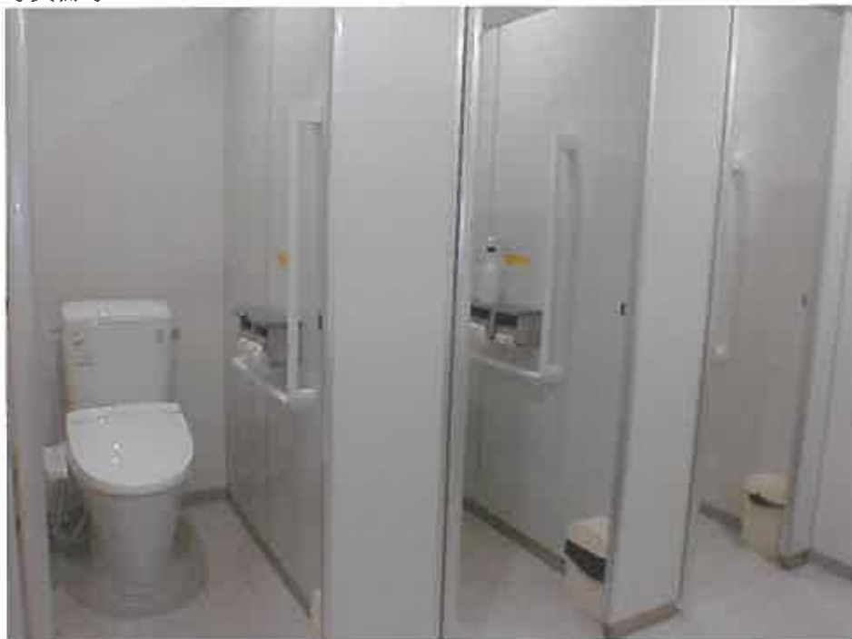
物件 2 1階トイレ
