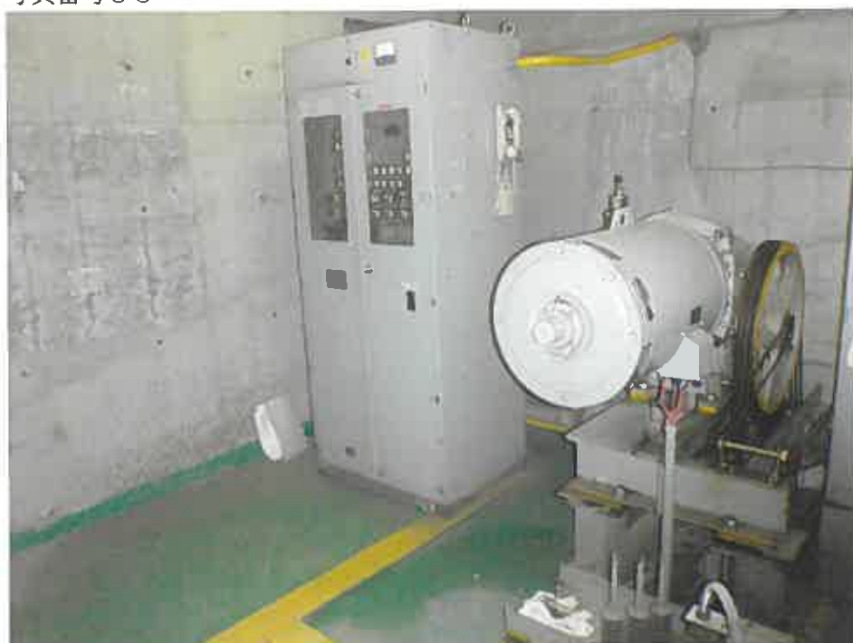
物件 2 5階エレベーター機械室
