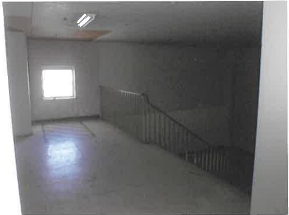
物件2 4階階段（北側）
