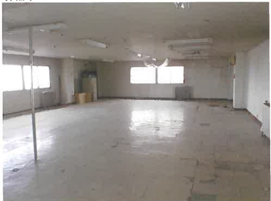
物件2 2階ロッカー室
