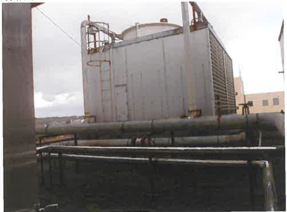
物件 2 屋上の水槽
