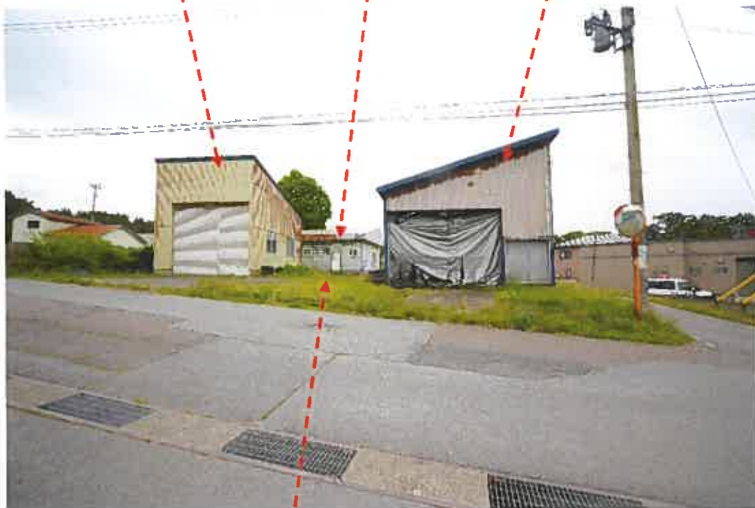
写真番号 2 物件 2 の未登記附属建物 物件 3 建物 物件 2 の主たる建物
