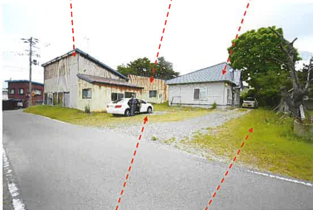
写真番号 1 物件 2 の主たる建物 物件 2 の未登記附属建物 物件 3 建物
