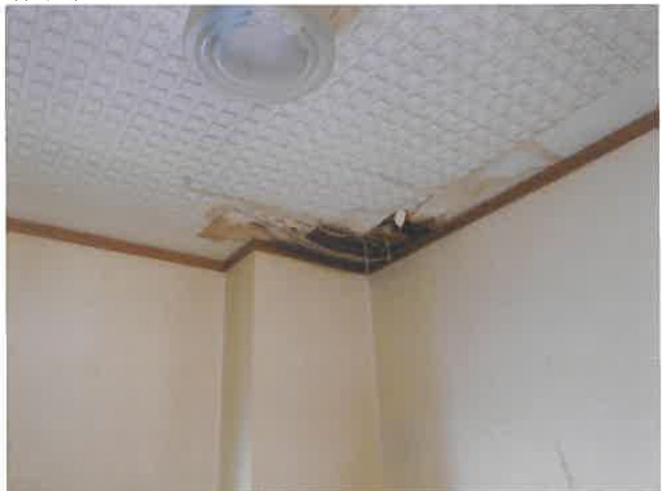
物件 2 2階和室（北東側）天井部分
