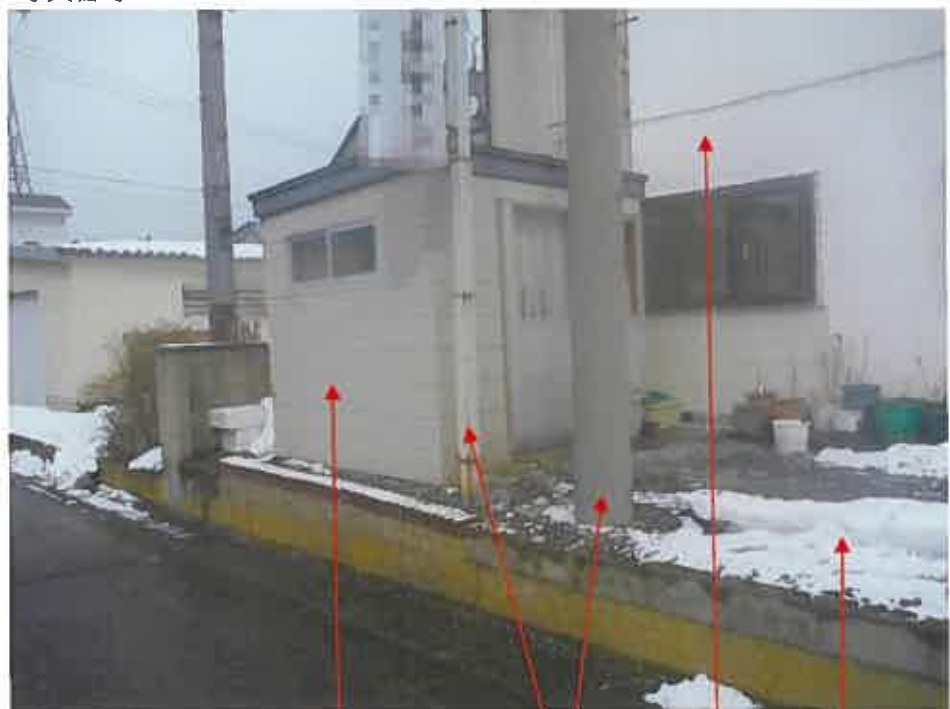
未登記附属建物 私設柱 物件 2 物件 1
