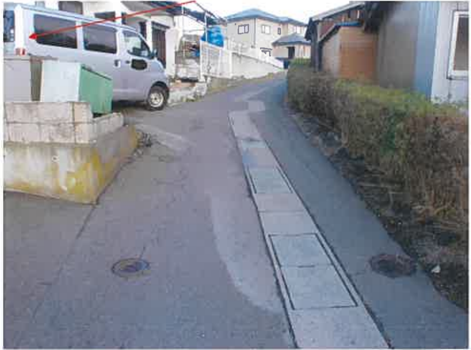
接面道路の状況
