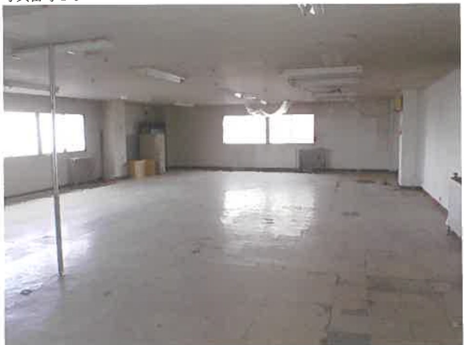
物件2 2階ロッカー室
