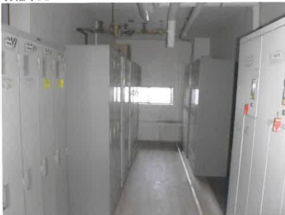
物件 2 1階更衣室
