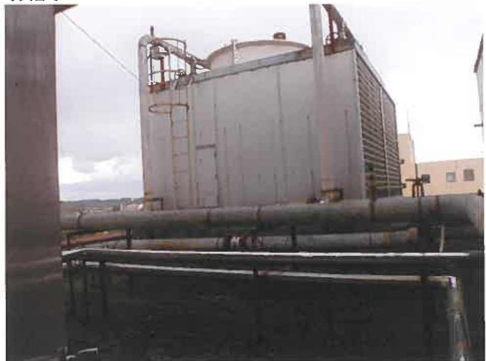
物件 2 屋上の水槽
