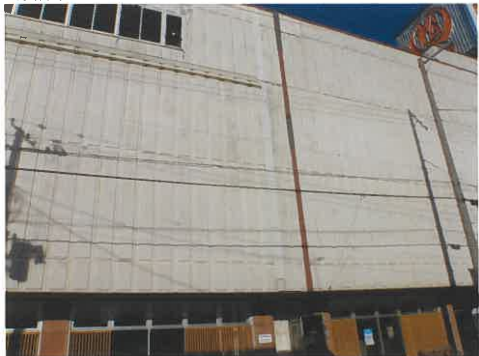
物件 2 南側外壁（補修されている模様）
