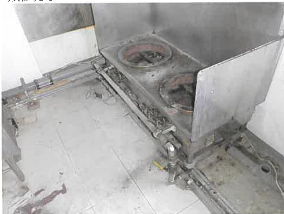
物件 2 3階厨房跡
