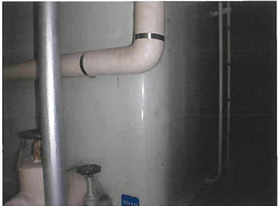
物件 2 5階水槽室
