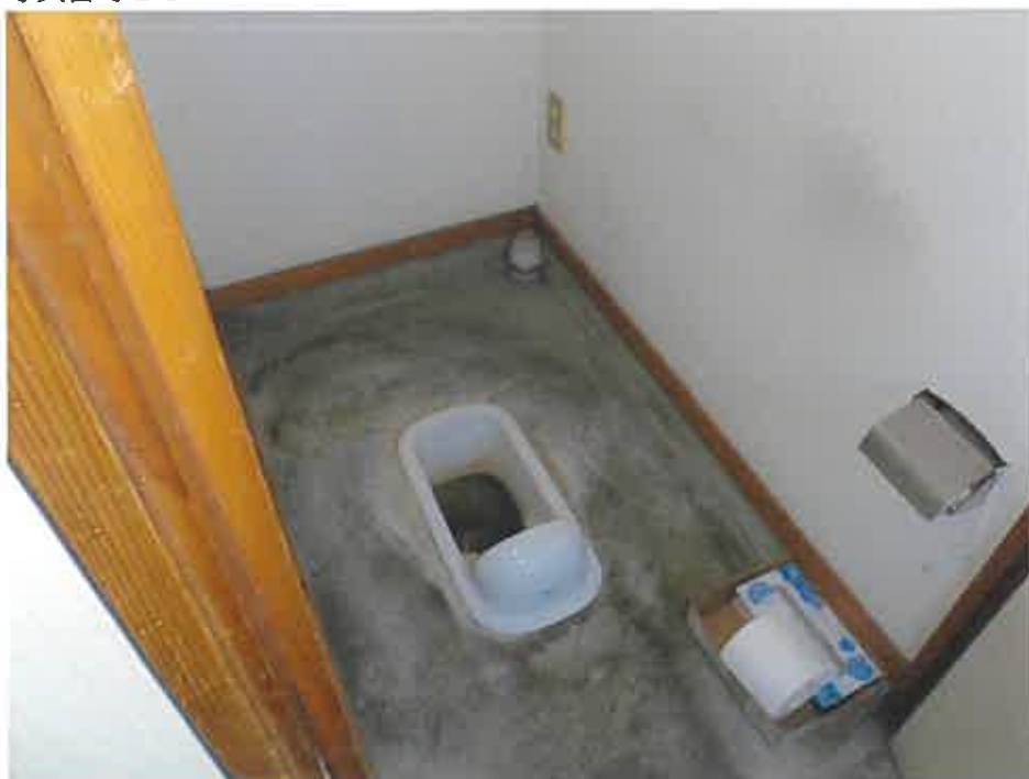
物件4附属建物符号5 トイレ
