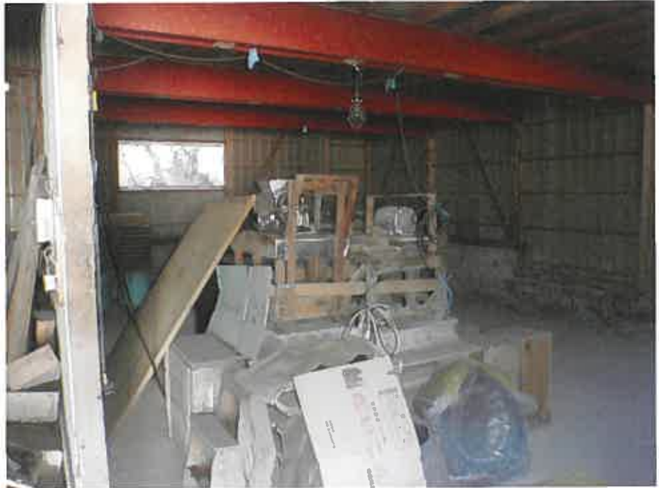
物件 4 附属建物符号 2 倉庫
