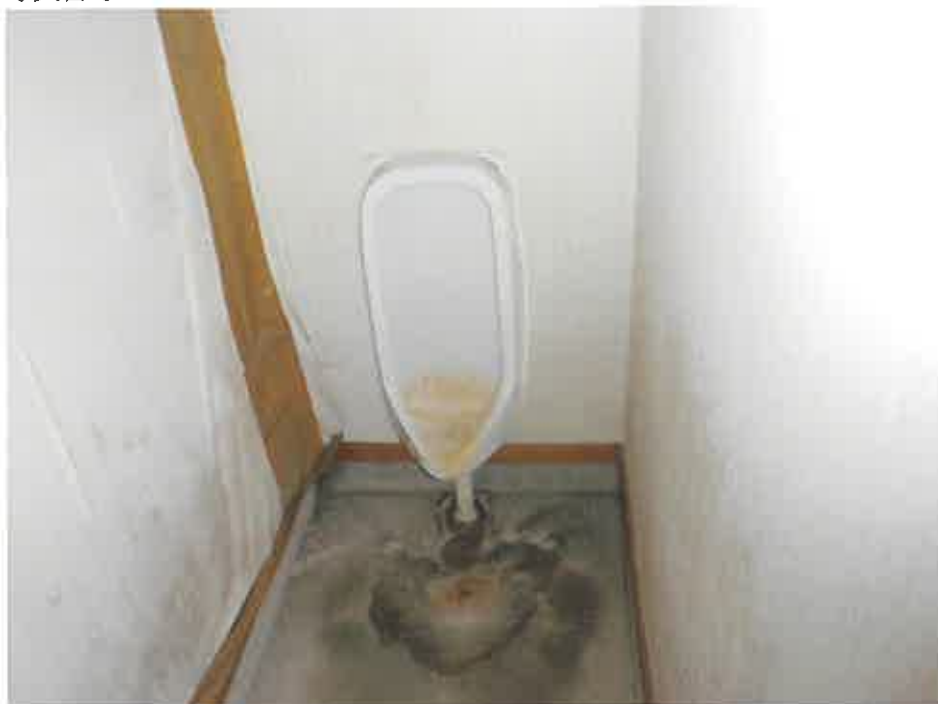
物件4附属建物符号4 トイレ
