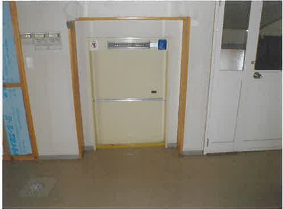
物件4 作業場脇の昇降機
