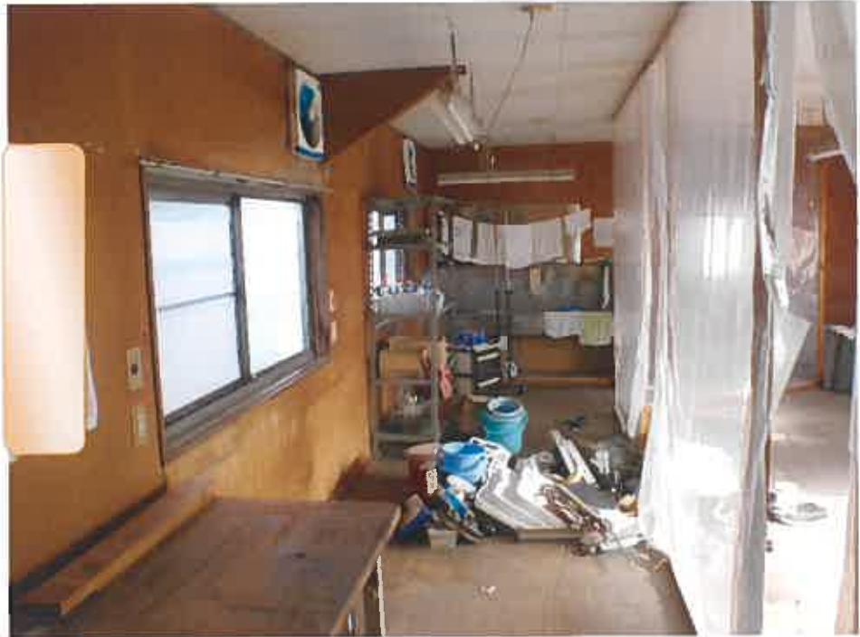
物件4 1階作業場
