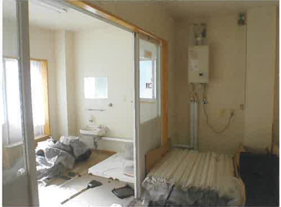
物件 4 1階廊下と北側玄関
