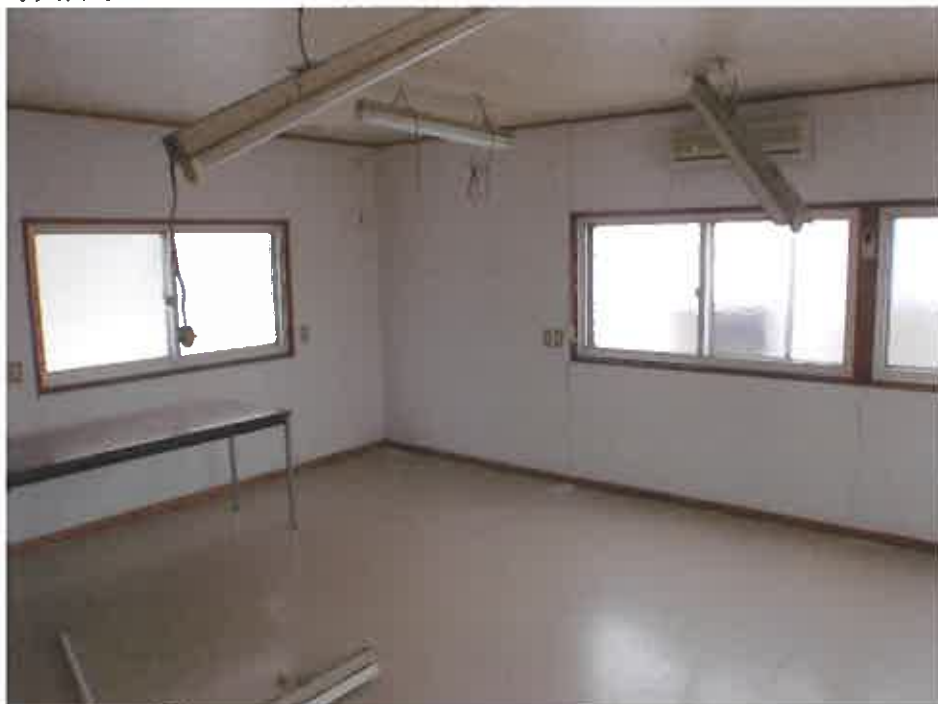
物件 5 2階作業場
