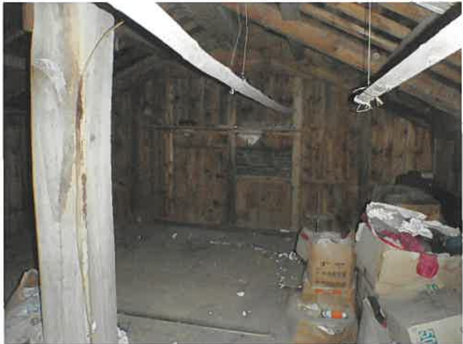
物件7 附属建物符号1 2階倉庫
