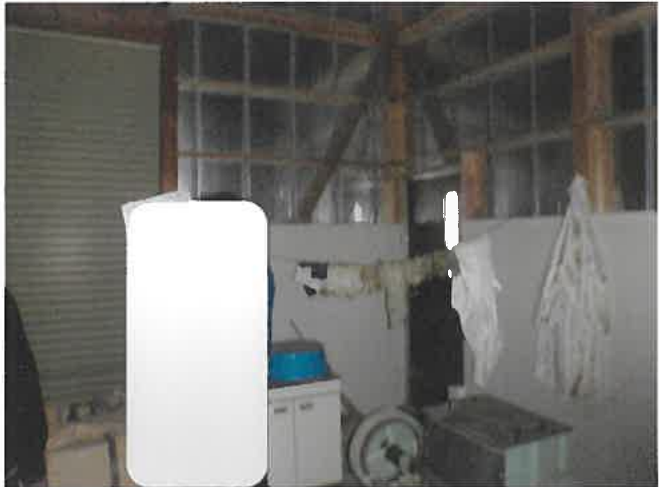
物件 7 附属建物符号 6 作業所
