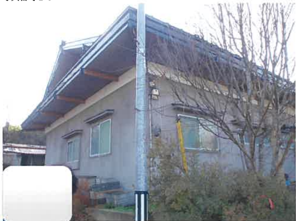
物件 1 北側境界付近の電柱と支線
