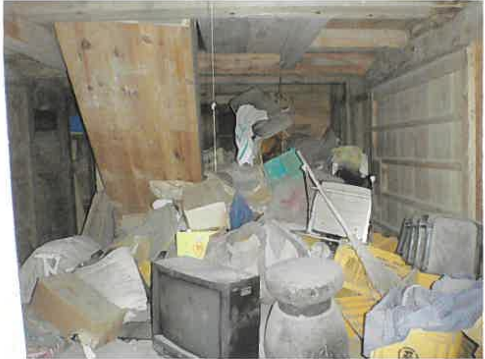
物件7 附属建物符号1 1階倉庫
