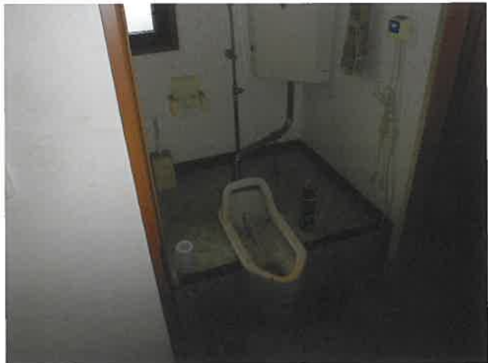
物件4 2階トイレ
