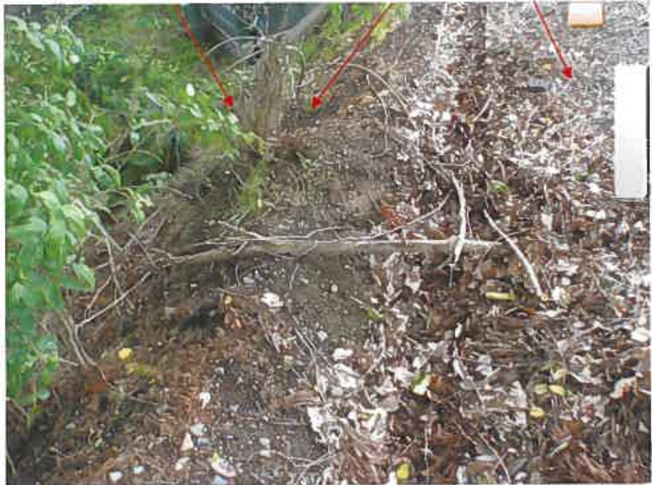
南東側法面の状況
