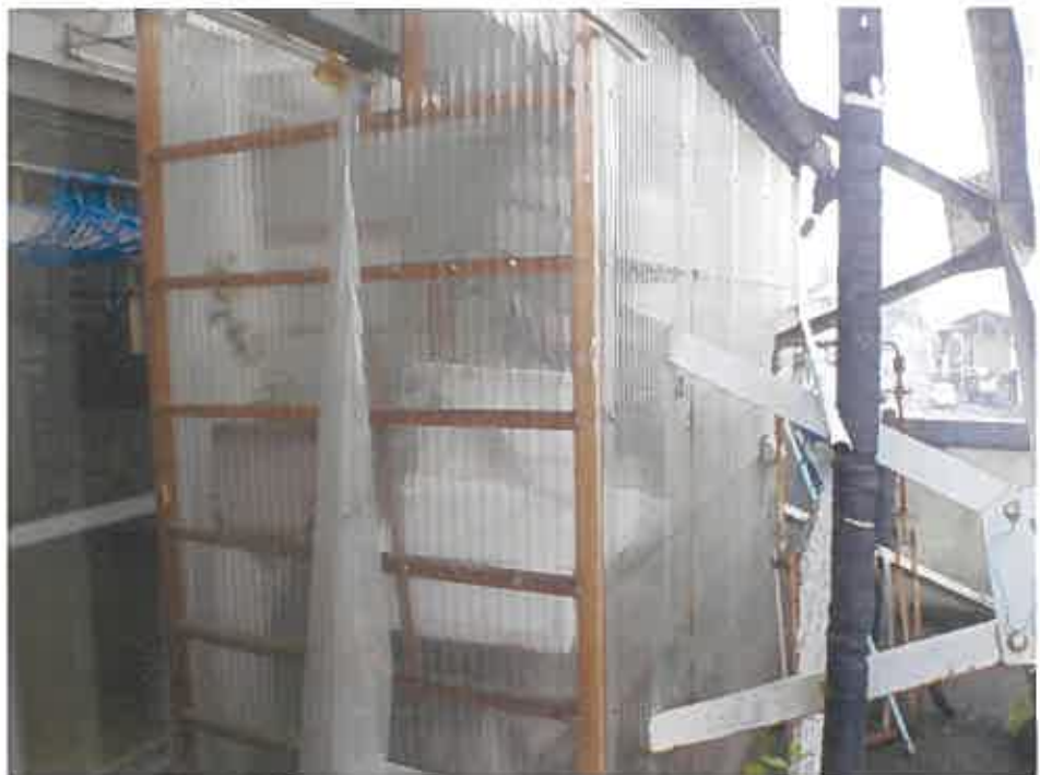
物件2 3階ベランダ部分の下屋
