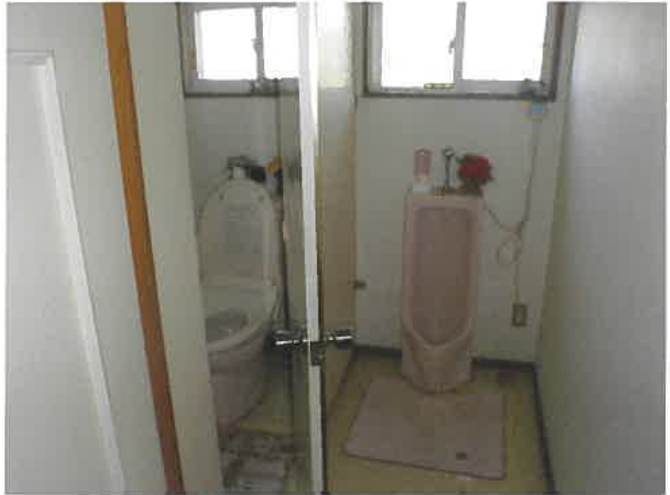
物件 2 1 階トイレ
