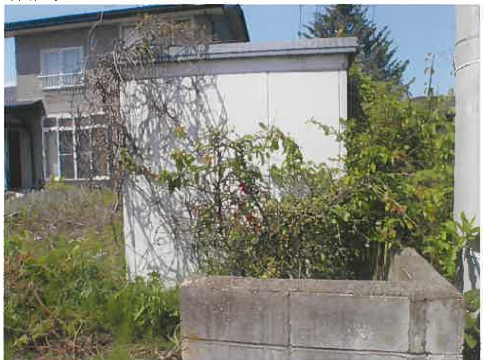
物件 1 南東側の物置
