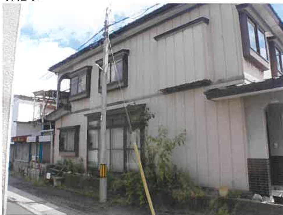
物件 1、2（南西側から）
