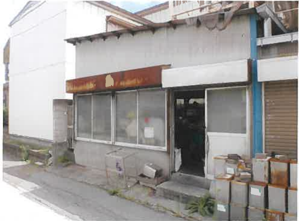
物件 2 附属建物符号 1 (作業場)
