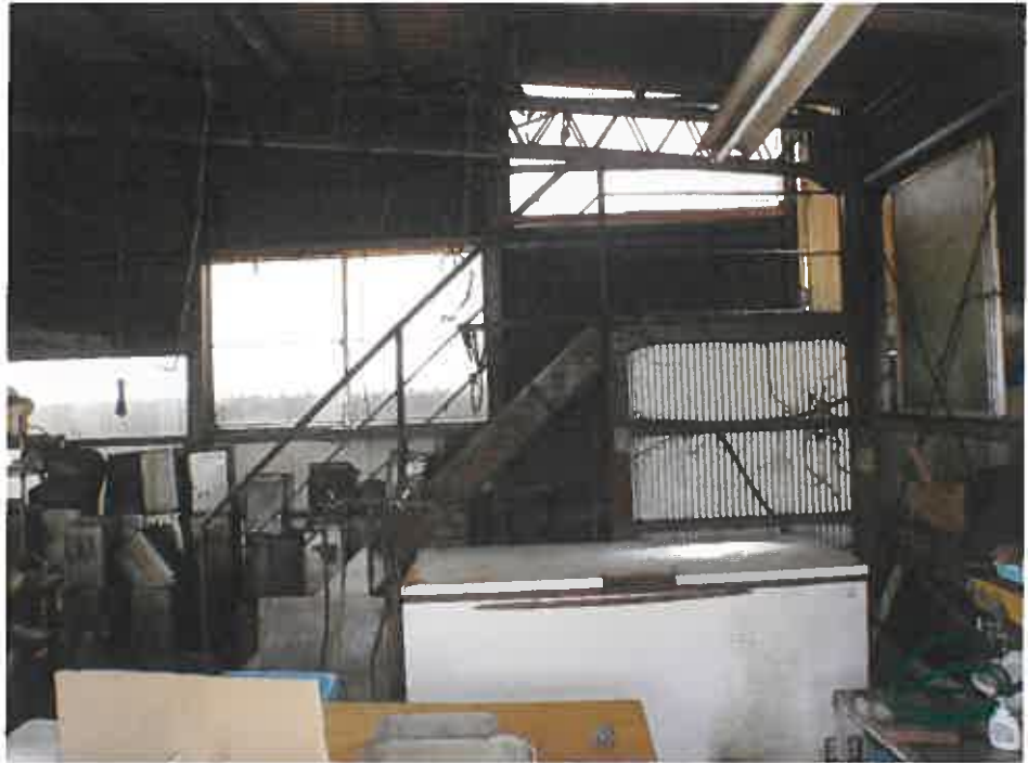
物件2 附属建物符号1（作業場）
