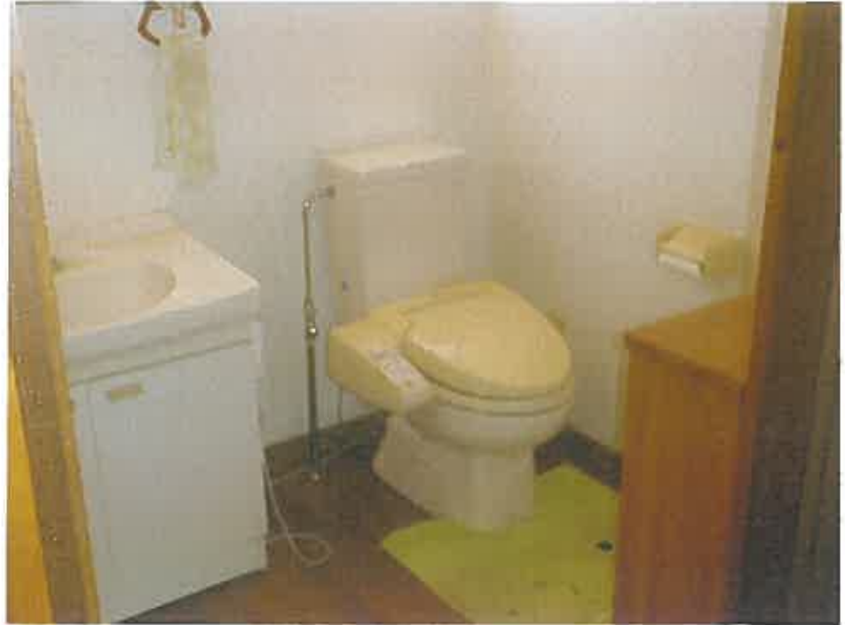
物件2 1階トイレ
