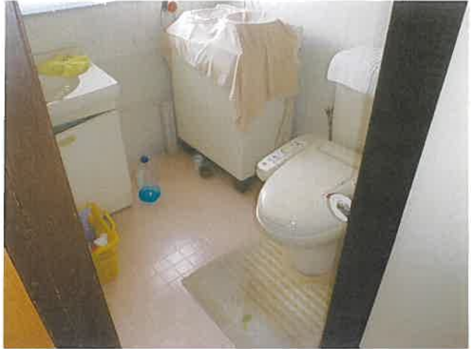
物件 2 2階トイレ
