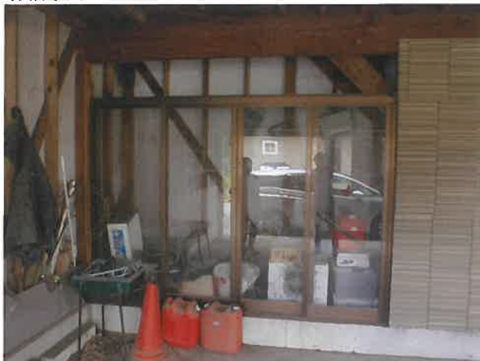
物件 2 未登記附属建物 (1 階)
