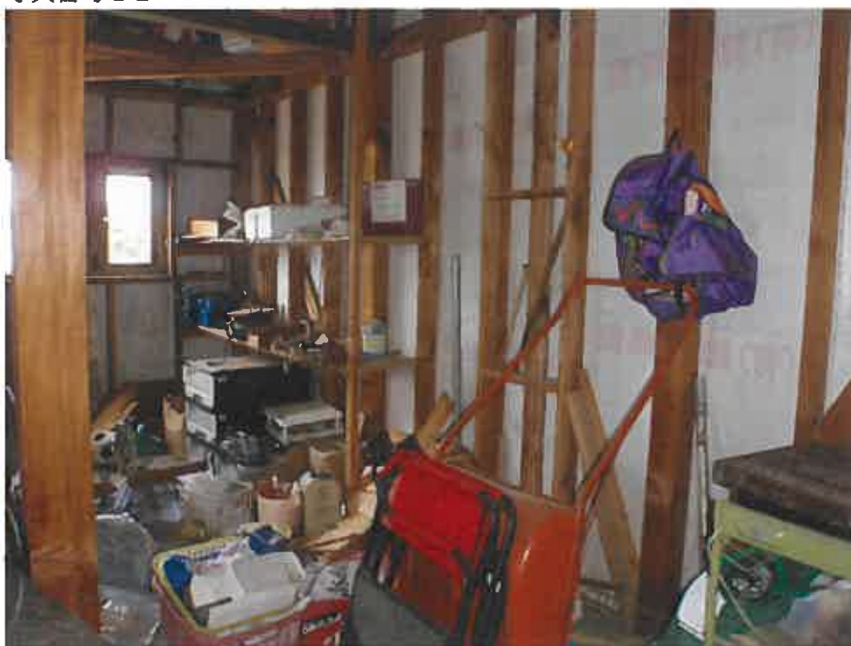
物件 2 未登記附属建物 (2 階)
