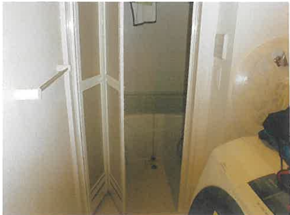
物件5 102号室洗面室から浴室
