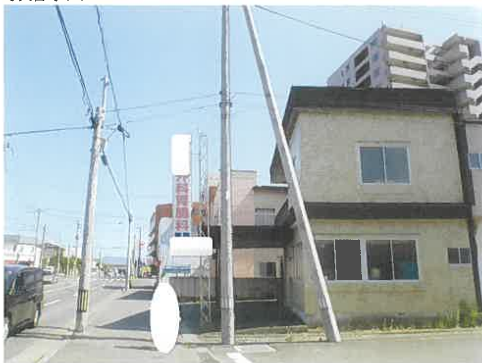
物件2上の電柱と支柱
