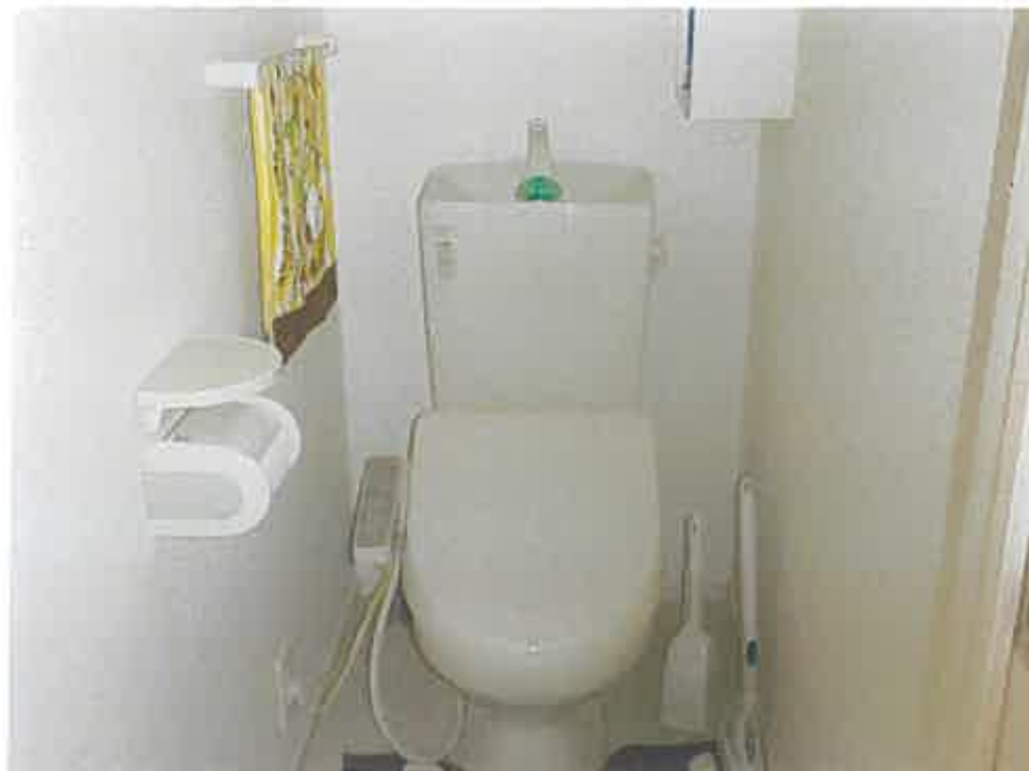
物件4 201号室トイレ
