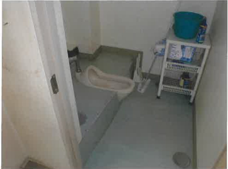
物件4 1階トイレ
