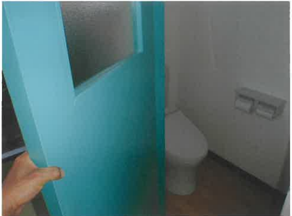
物件2 2階トイレ
