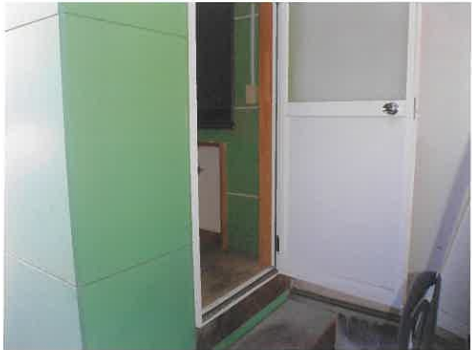
物件 4 1 階倉庫口
