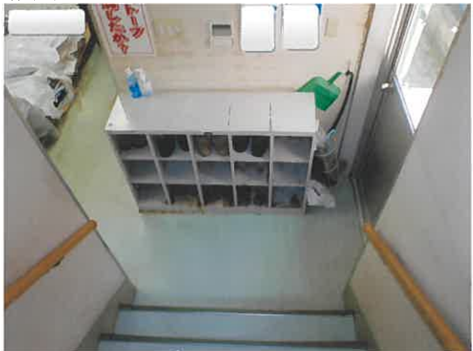
物件4 中央付近階段から1階方向
