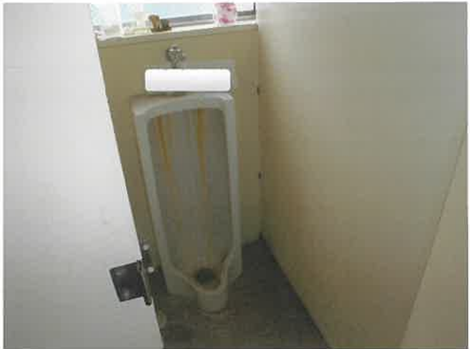
物件 2 2階トイレ
