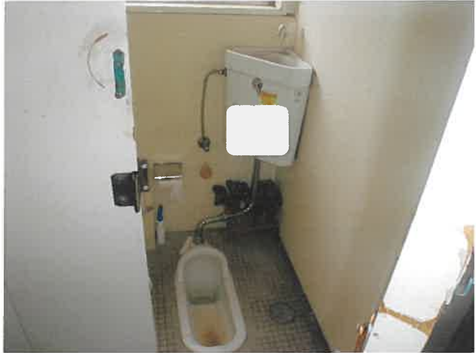
物件2 2階トイレ
