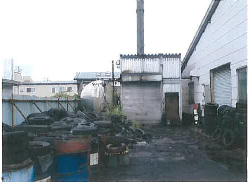
物件 1 上の物件 4 未登記附属建物
