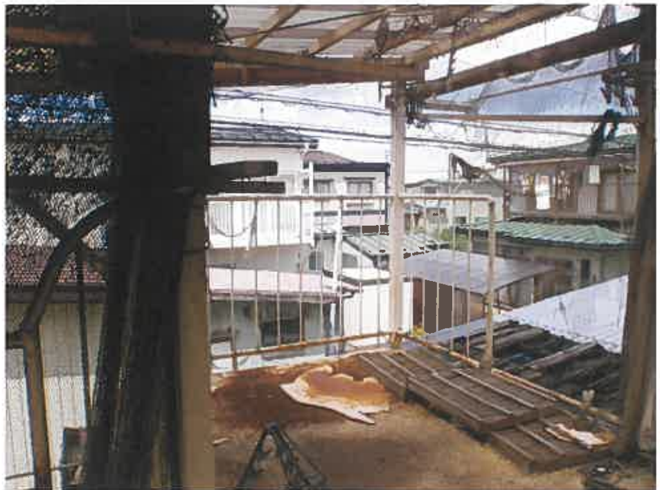
物件2 附属建物符号1 (作業場) 上のベランダ
