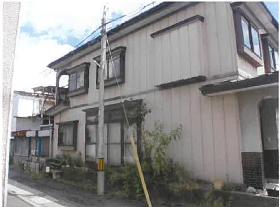
物件 1、2 (南西側から)
