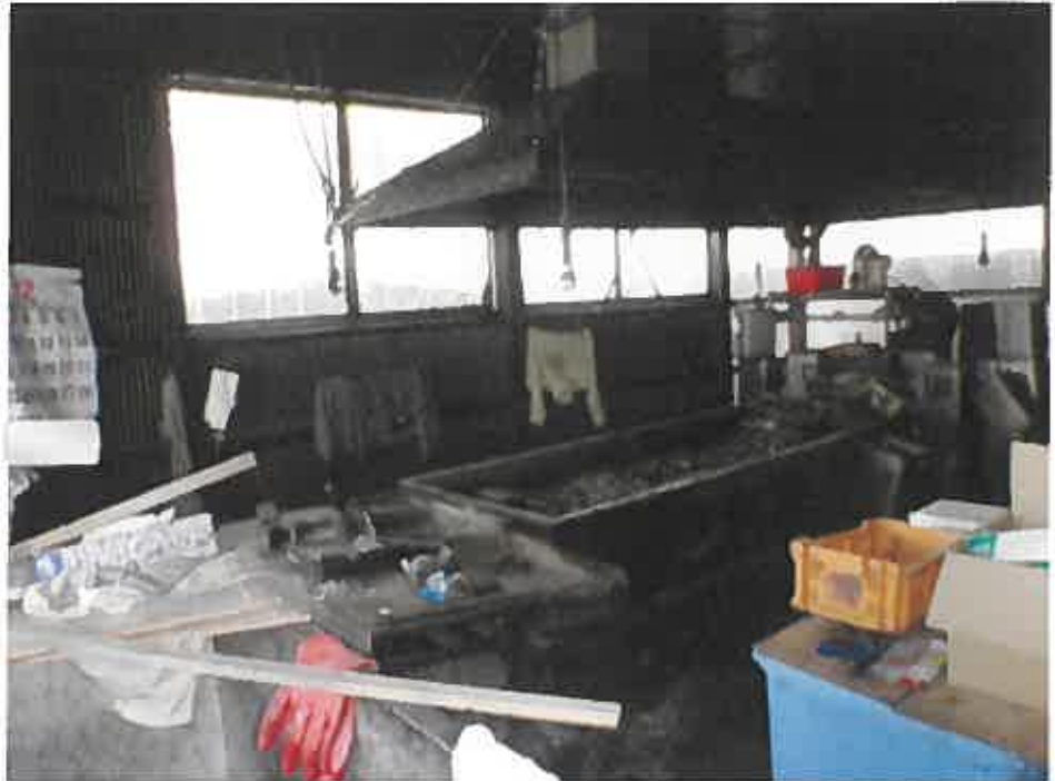
物件2 附属建物符号1 (作業場)
