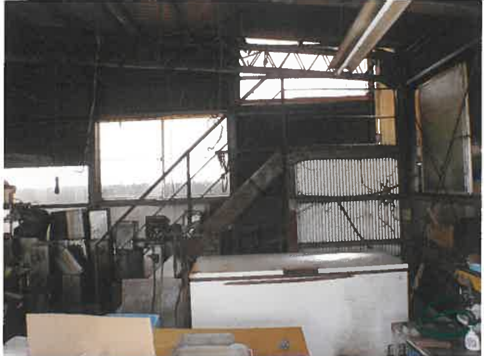
物件2 附属建物符号1 (作業場)
