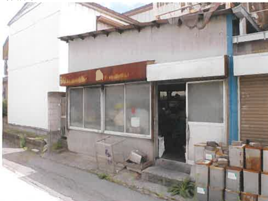
物件2 附属建物符号1 (作業場)
