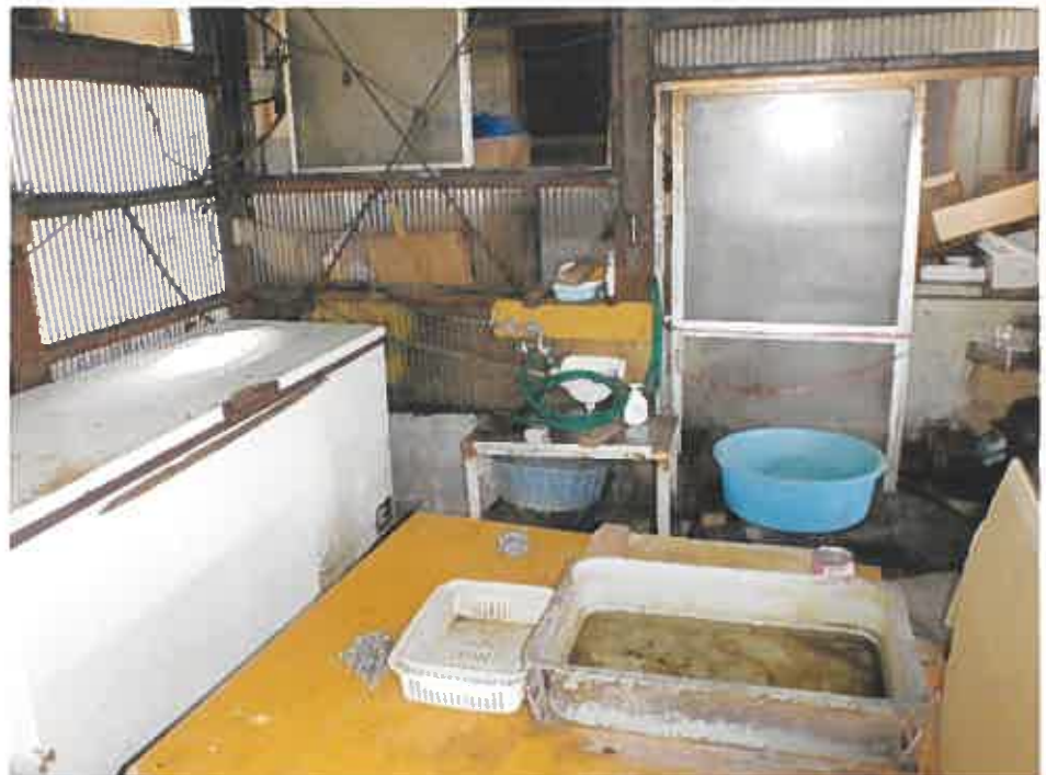
物件2 附属建物符号1 (作業場)
