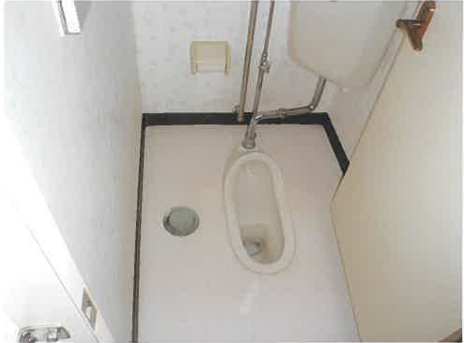
物件2 1階トイレ
