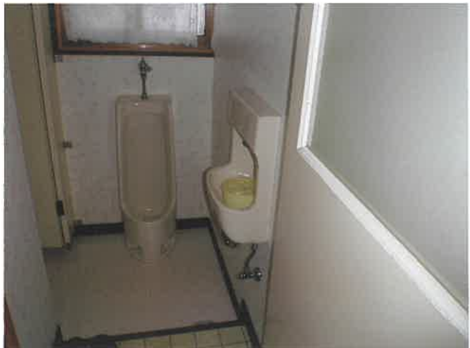
物件 2 1階トイレ
