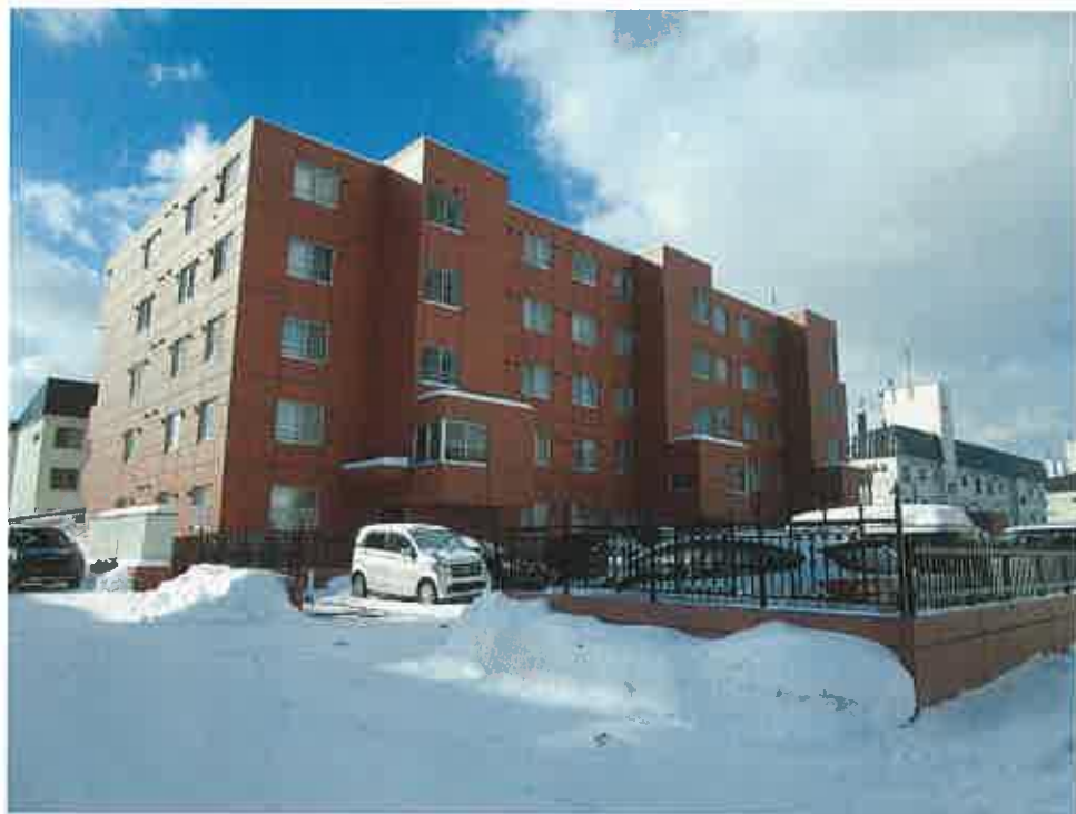
全景(西側から撮影)
