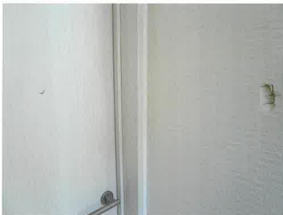
洋室2の前の壁
