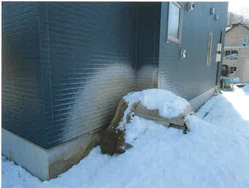
北側部分の外壁
