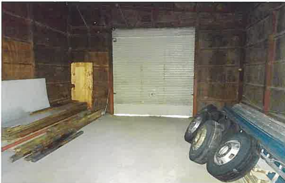
1 1 車庫（物件6の増築部分）
