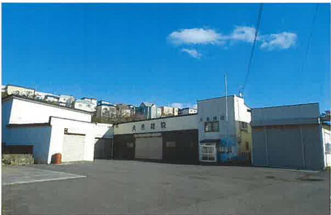
6 建物外観（物件5ないし同7）
