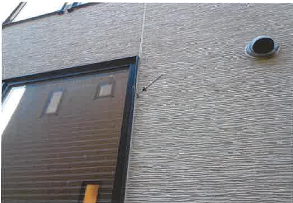
外壁の損傷
