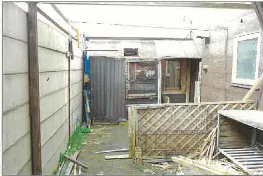
⑤下屋状の木製仮設倉庫
