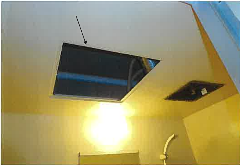
浴室の点検口の状況
