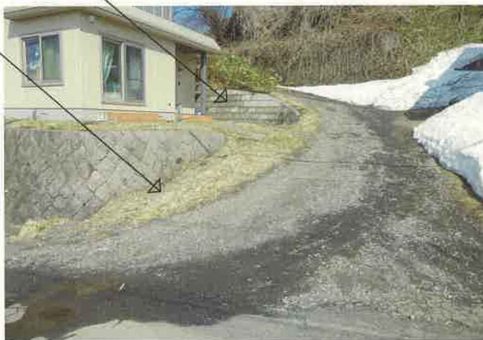
物件 3 ・ コンクリートブロック擁壁
