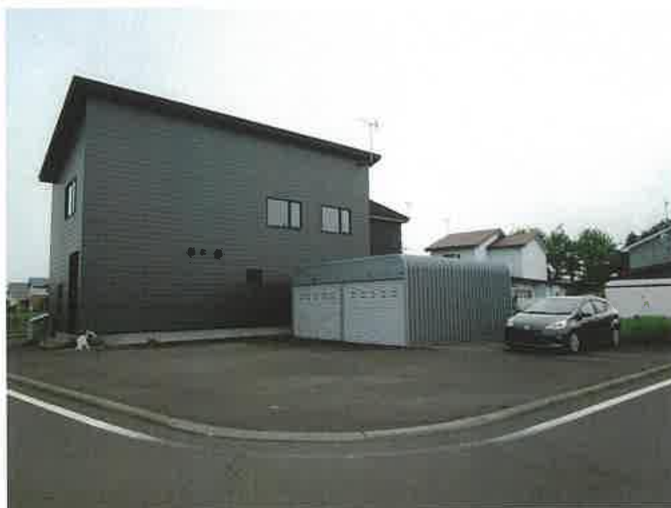
全景, 仮設物置(北側から撮影)
