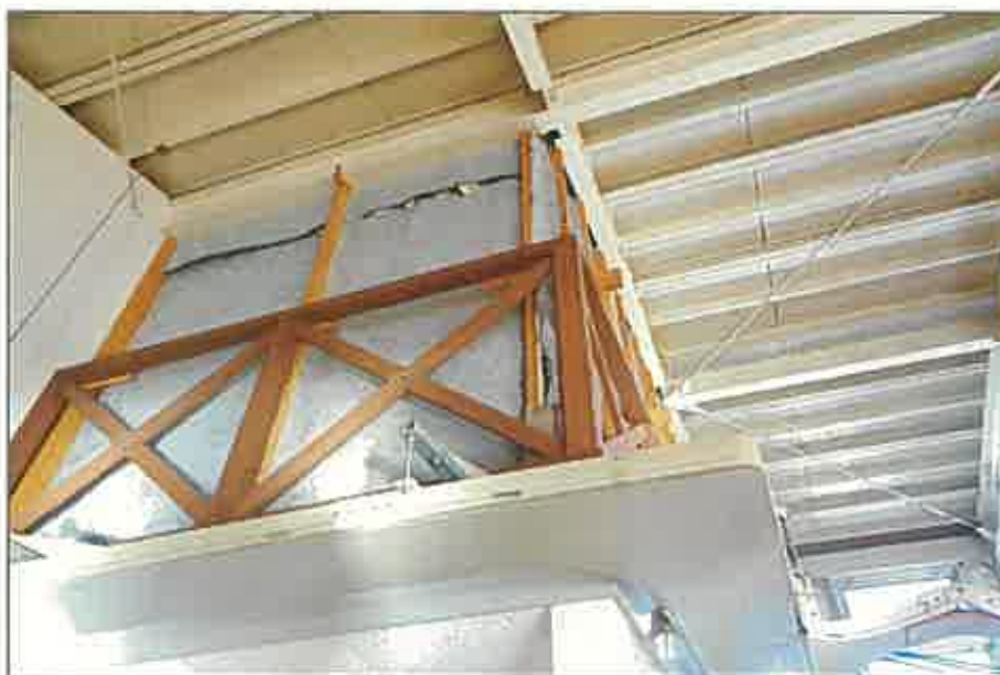
⑭2階事務室(1階から撮影)
