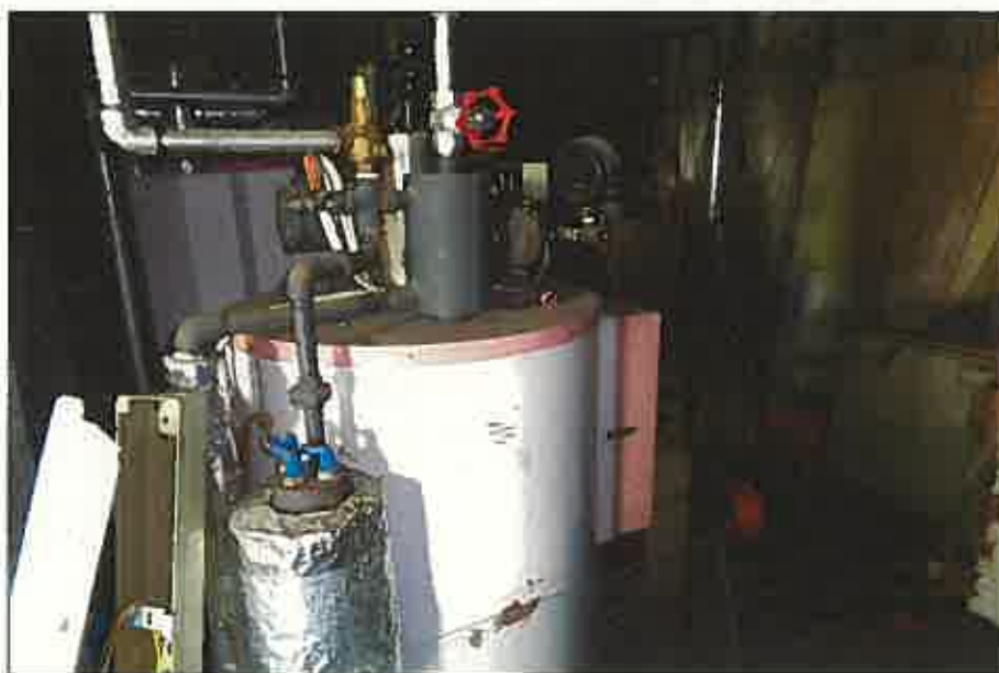
⑬物件4(機械室)
