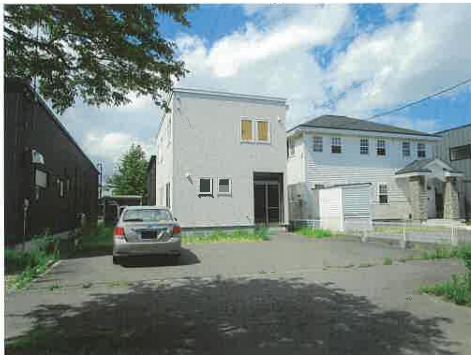
全景(南側から撮影)
