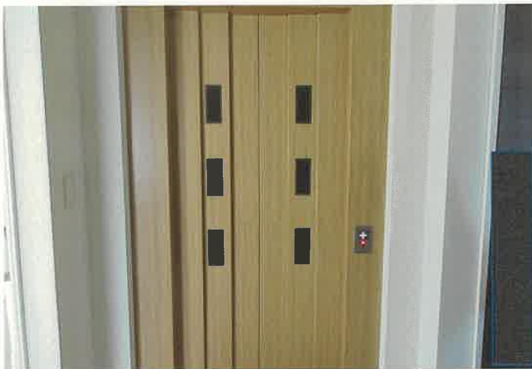
7 エレベーター①
