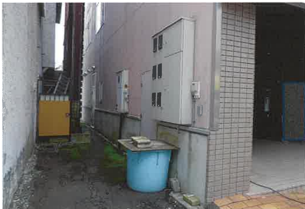
1階 物置出入口付近
