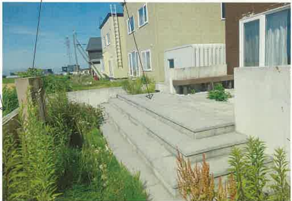
コンクリート造土留・コンクリート造水場・コンクリート造テラス
