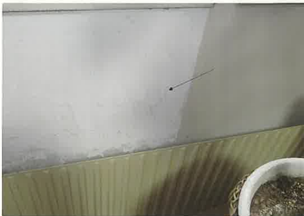
5 1階居間内壁（漆喰塗りの状況）
