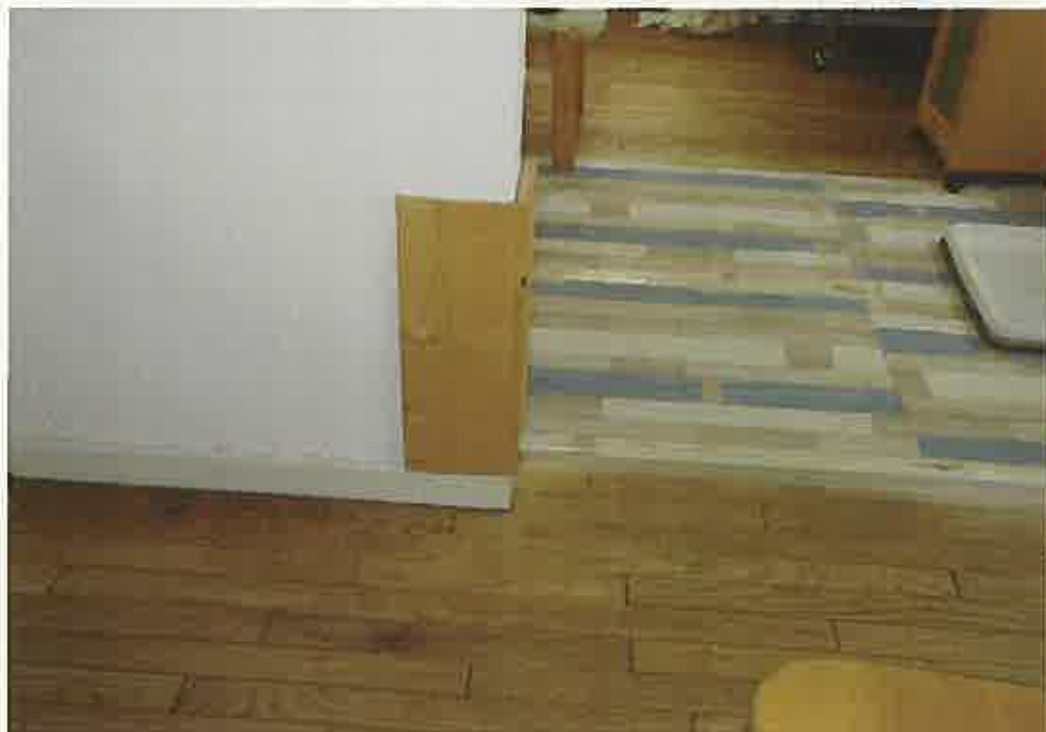
7 1階内壁（木板補修状況）
