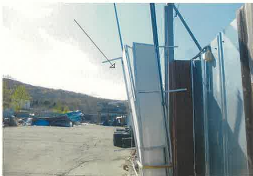
スチール製柱付パネルゲートの状況
