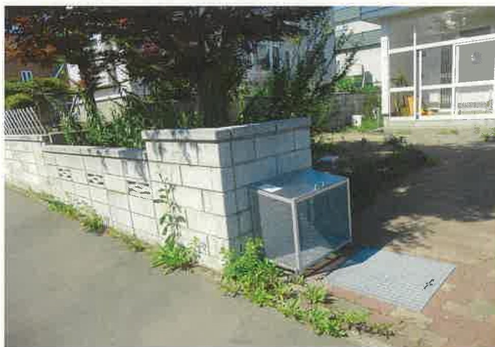
コンクリートブロック塀（南西側市道付近）・融雪槽・スチール製仮設ゴミ箱
