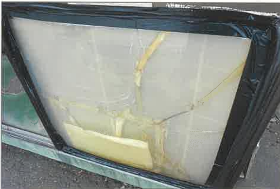
⑯物件4(風除室のガラス)
