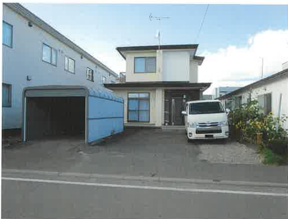
全景，仮設車庫（南東側から撮影）
