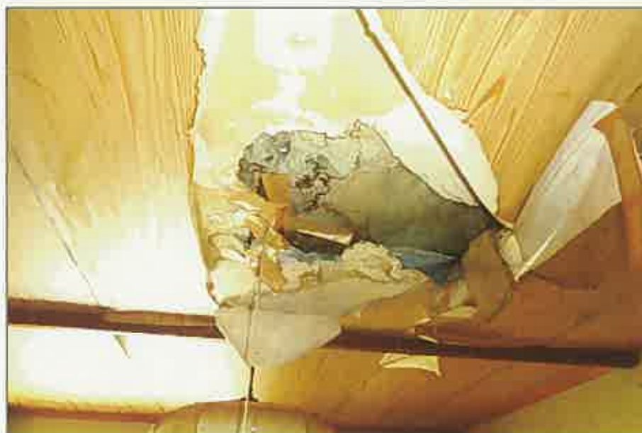
⑥和室3の天井の状況
