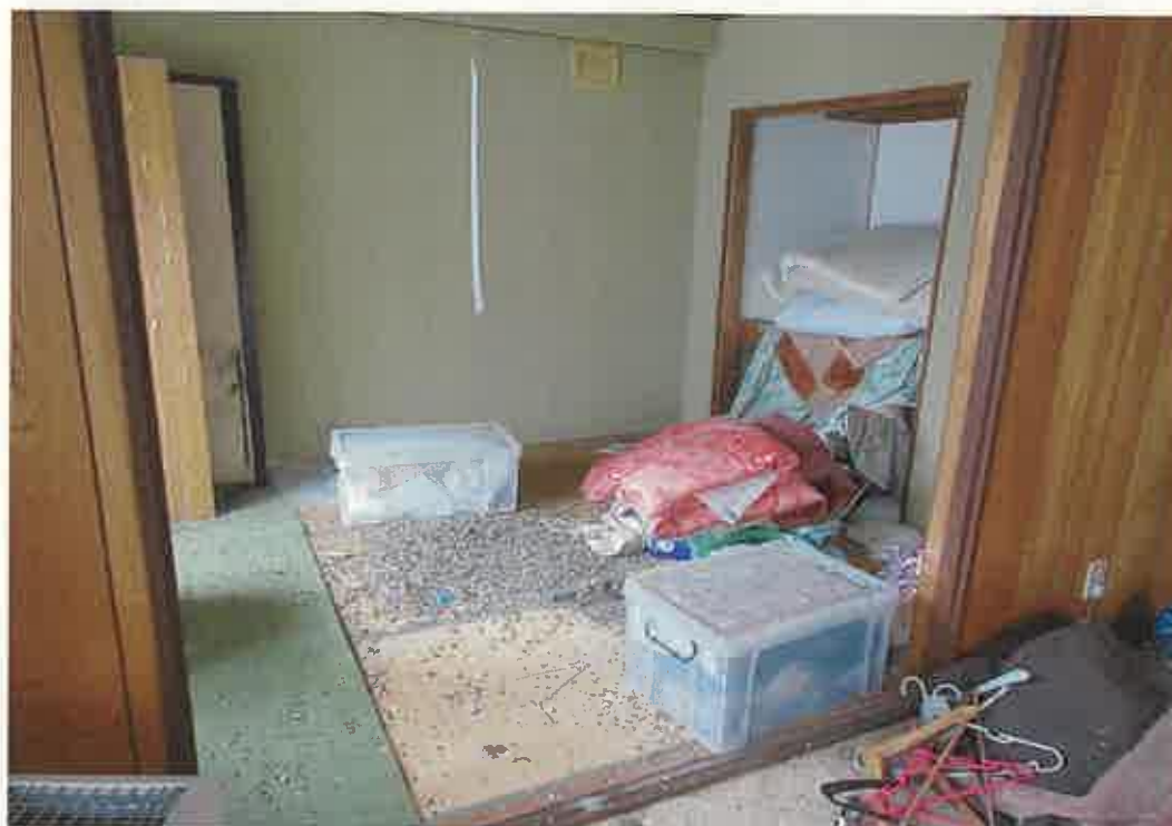
8 2階和室（汚損状況）
