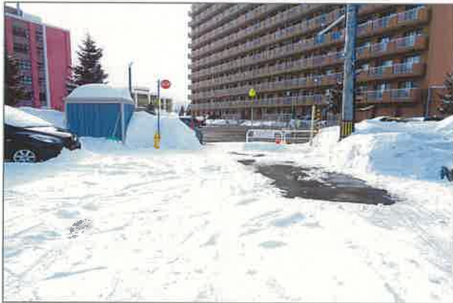
⑦篠路中央北4号線との接道部分
