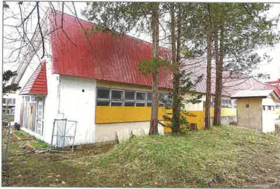
⑤物件4(南東側部分)
