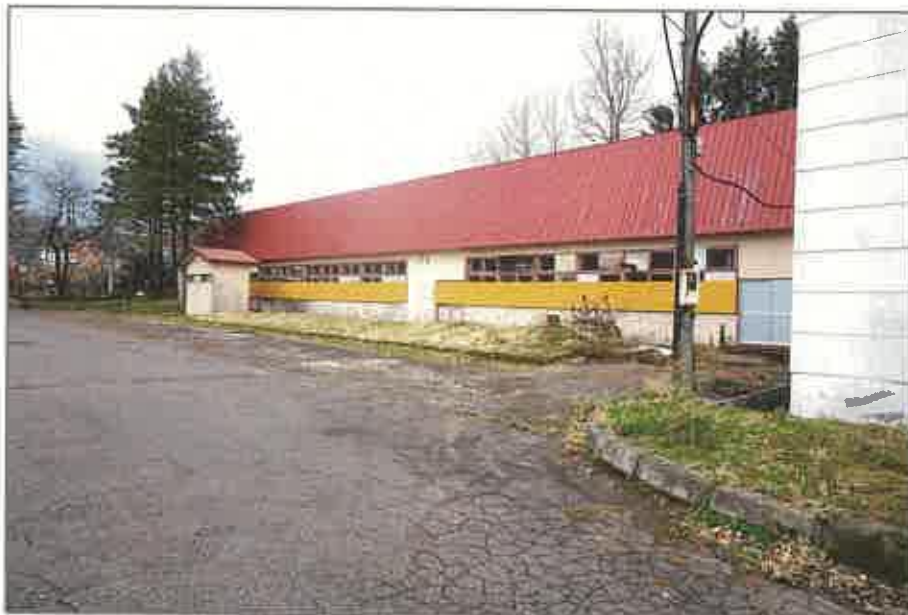
②物件4(南東側部分)
