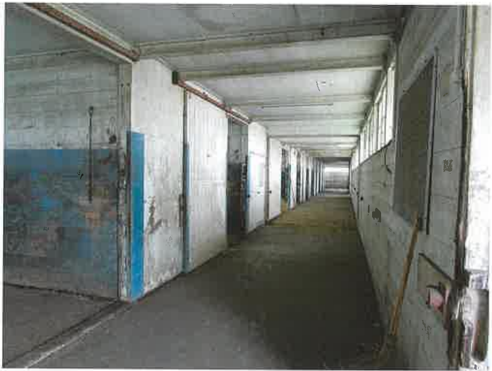
同北西側通路から南東側を撮影
