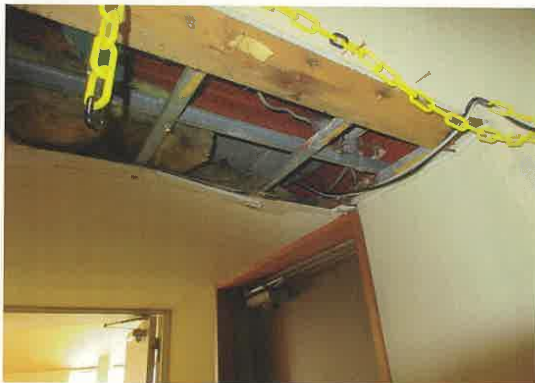
16 3階通路天井（損壊状況）
