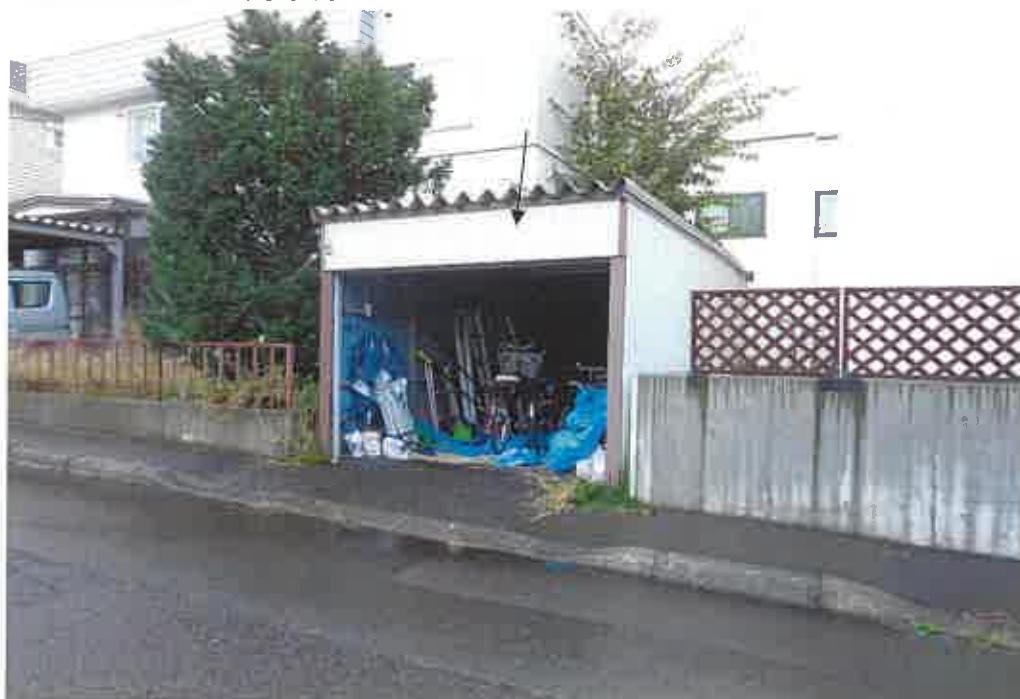
軽量鉄骨造付属車庫
