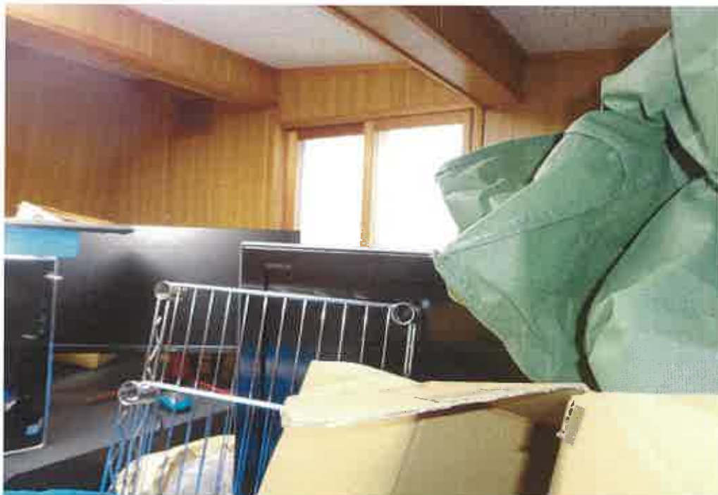
小屋裏の状況
