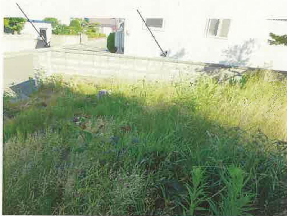
コンクリートブロック塀の状況（北西側より撮影）
