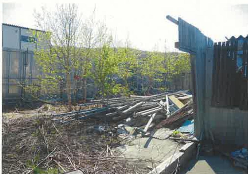
物件内（南西側付近を撮影）
