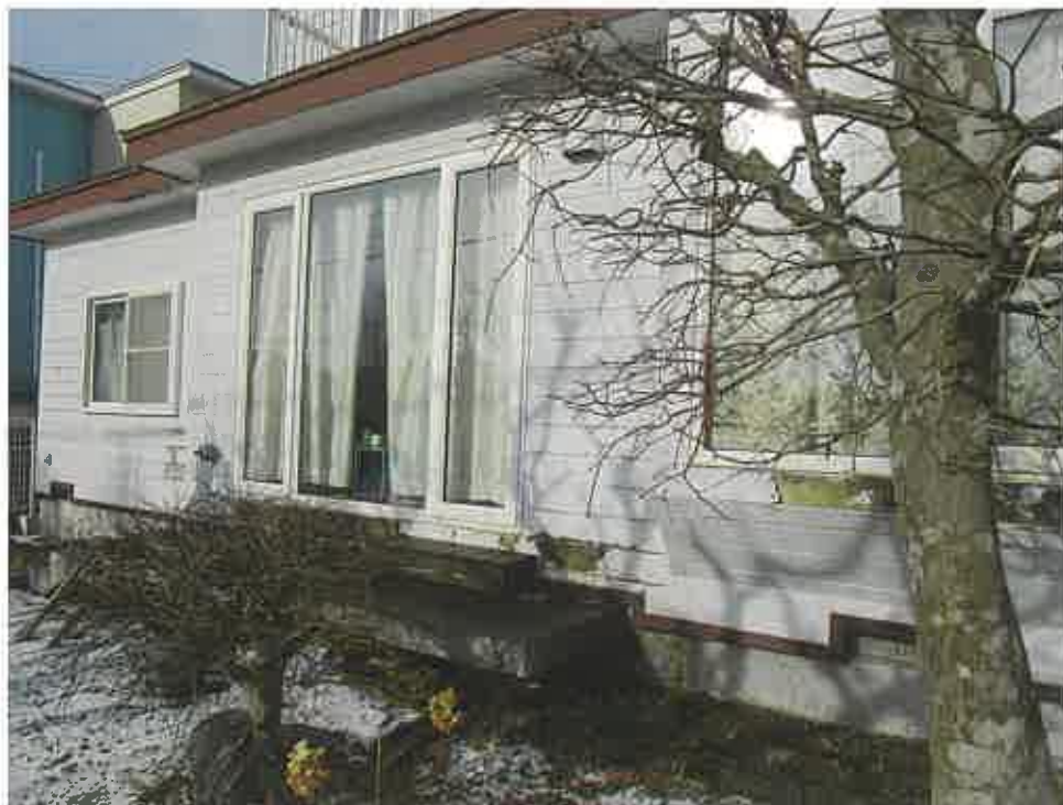
南側外壁, 軒天の状況
